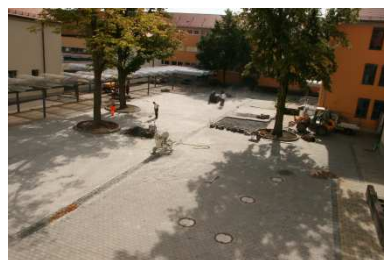
Fast fertig gepflastert.
