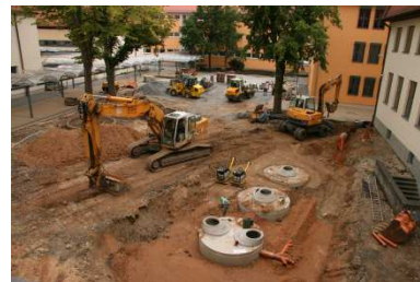
Setzen der Zisternen.
