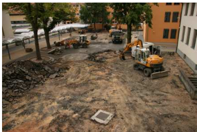
Abräumen der alten Asphaltdecke.
