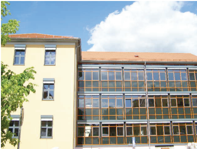
Die Südansicht unseres neuen Anbaus
