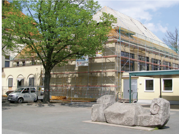
Die alte Turnhalle im Umbau zur Aula
